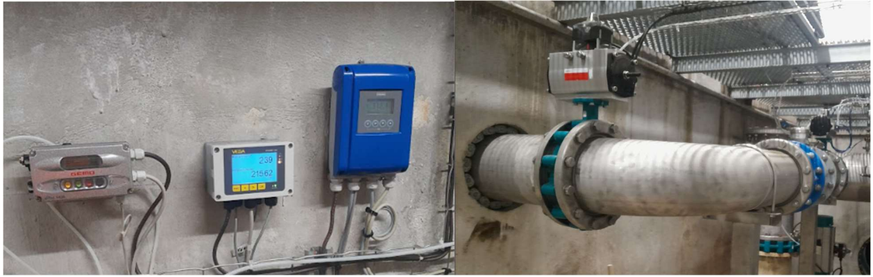
Photos du chantier de renouvellement des Polhydras
