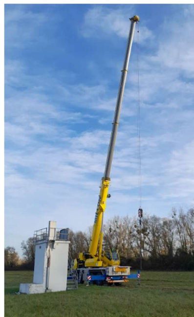
Photos du chantier de renouvellement de la pompe
