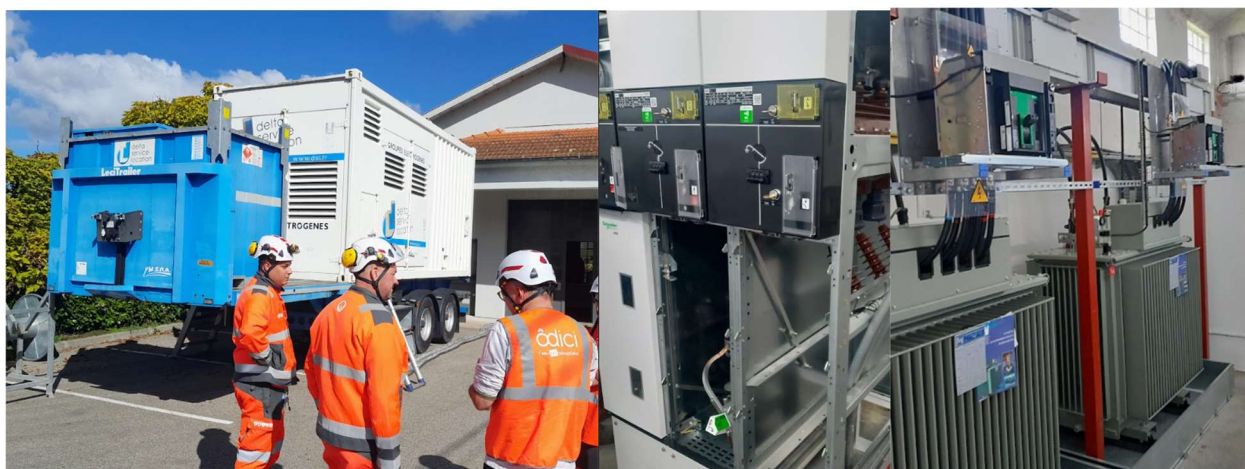
Photos des travaux de renouvellement
