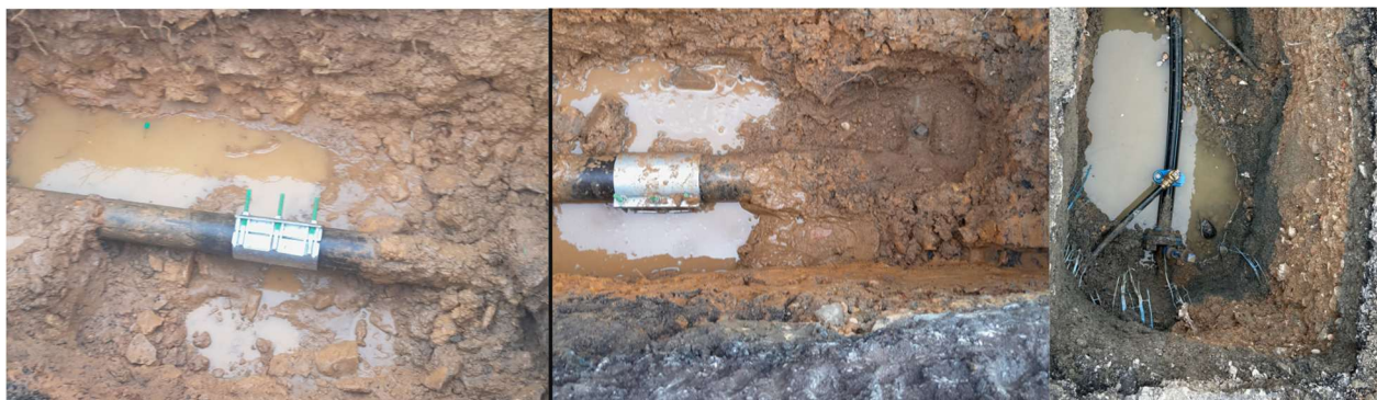
Photos de réparation de fuites
