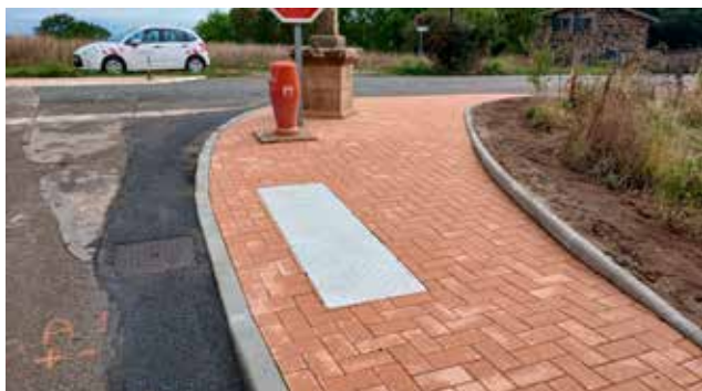
Travaux de voirie des Maisons Neuves à Montmelas-Saint-Sorlin
