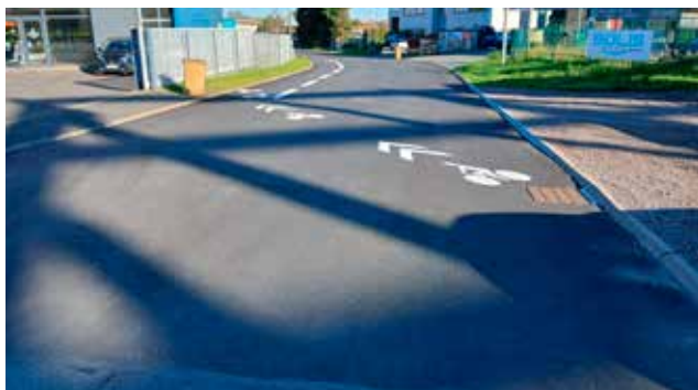
Travaux de voirie route des Fresnes à Arnas
