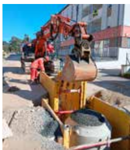
Travaux de mise en séparatif du réseau d'assainissement - rue Edouard Herriot à Jassans-Riottier
