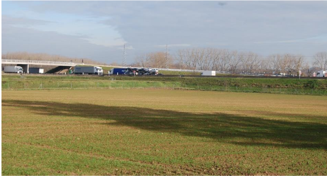
Vue depuis la plaine à l'Ouest, l'autoroute A6, établi sur remblai, forme un écran visuel.
