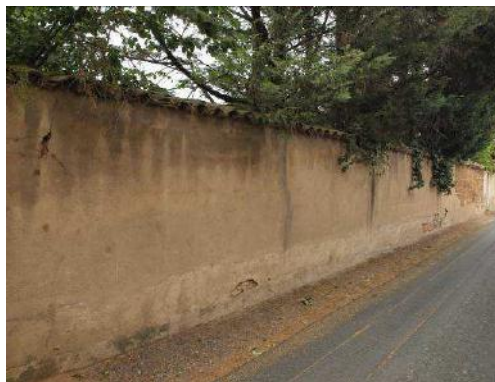
exemple de mur maçonné enduit et protégé par une couverture en tuiles creuses
