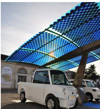
« ombrières » photovoltaïques sur un parking
