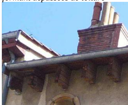
dépassée de toiture à chevrons débordant sculptés
