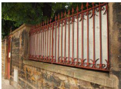
clôture en fer forgé à conserver
