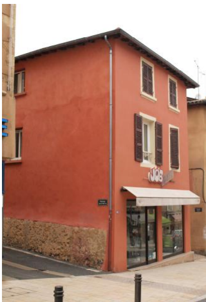
enduit traditionnel à la chaux rue Nationale
