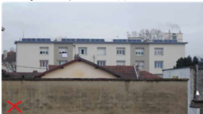
(à droite) Panneaux sans adéquation avec la rythmique architecturale (ouvertures et couleurs de façade), Villefranche (à gauche) Vue sur le côté des panneaux en cohérence avec le pignon de l'immeuble, mais générant une forme en chapeau (inclinaison forte), sans rapport avec l'architecture (donc rabaisser le plus possible les panneaux à l'horizontal)
