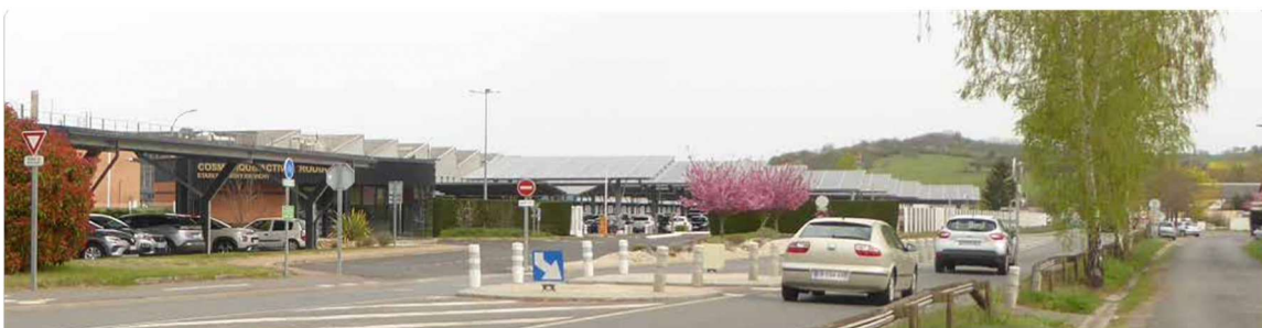
Deux types d'ombrières inscrites dans leur contexte urbain : alignement au bâti dont toitures en shed, maintien du cône de vue sur un mont agricole et boisé, végétalisation de l'espace public, Vichy.
