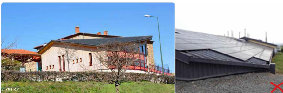
Panneaux se fondant sur tout le pan incliné et courbe d'une cantine scolaire. Les panneaux « full black » créent un effet d'ensemble sans rendre visible chaque module, annexe de l'école, Loire
