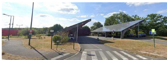
Identité architecturale par une inclinaison notable, une structure en bois lamellé collé, Zone d'activités des Loges, Loiret
