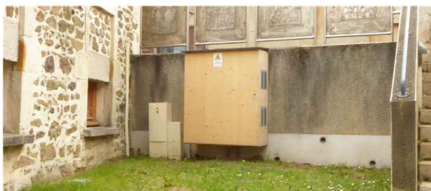
Ci-dessus, onduleurs accompagnant deux toitures photovoltaïques sur des équipements publics d'un village : emplacement à l'arrière de la rue principale, dans une cour arrière peu fréquentée, accolé au mur, alignement à la hauteur du muret, bardage bois, petite toiture en zinc sombre, ventilations placées sur le côté et non en façade... sont autant d'éléments intégrant le dispositif. Chuyer (69).
