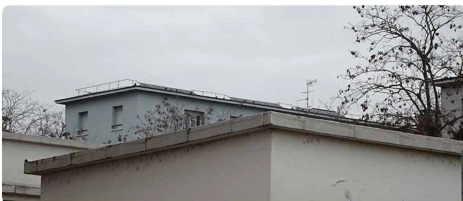
Petite marge de recul depuis le rebord de façade et inclinaison atténuant la visibilité des panneaux
