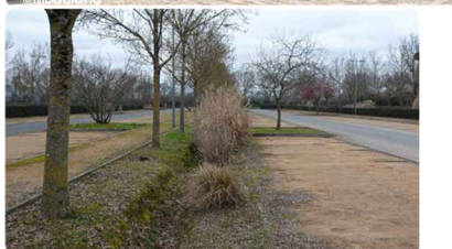
Surfaces de stationnement désimperméabilisées fossé enherbé de récolte des eaux pluviales, plantations, complexe sportif, Arnas
