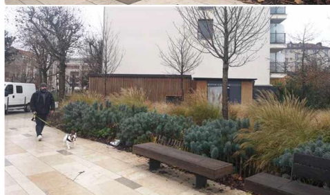
Deux photos ci-dessus : Intégration d'un poste de transformation en cœur urbain, adossé à un pignon d'immeuble. Habillage en lattes de bois verticales, ouvertures, couverture en bas acier sombre. Toilettes publiques attenantes du même habillage. Montrouge (92).
