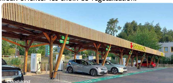
Ombrière en structure et façade bois, revêtement de stationnement en dalles poreuses
