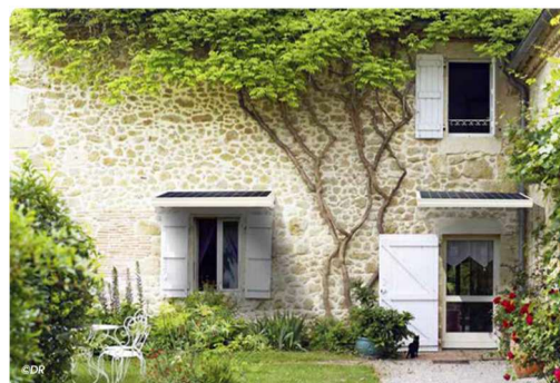
Brise-soleil au-dessus d'ouvertures sur une façade en pierres végétalisée
