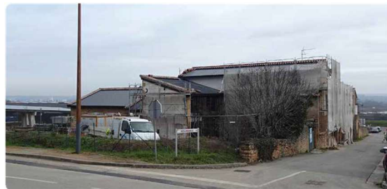
Mise en œuvre en cours de panneaux photovoltaïques sur tous les pans d'une maison traditionnelle et ses dépendances. La couverture sur la totalité des surfaces et en encastrement devrait garantir une bonne intégration. Hameau à Pommiers
