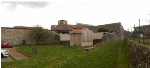
Ci-dessus, onduleurs accompagnant deux toitures photovoltaïques sur des équipements publics d'un village : emplacement à l'arrière de la rue principale, dans une cour arrière peu fréquentée, accolé au mur, alignement à la hauteur du muret, bardage bois, petite toiture en zinc sombre, ventilations placées sur le côté et non en façade... sont autant d'éléments intégrant le dispositif. Chuyer (69).
