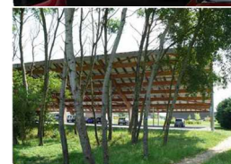
Bandeau en bois sous la gouttière en façade et totalité de la structure en bois, dont lamellé-collé, zone d'activités du Loiret (45)
