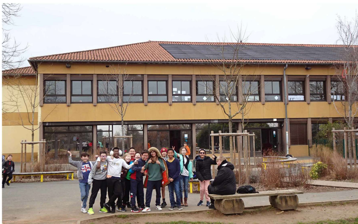
Toiture photovoltaïque de l'école Ferdinand Gayot, Limas (195m 2 pour 36kWc, 2011)
