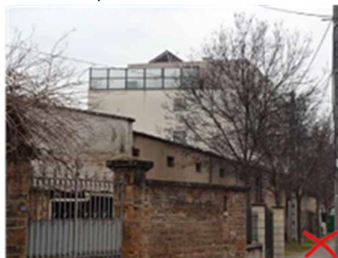
(à droite) Panneaux sans adéquation avec la rythmique architecturale (ouvertures et couleurs de façade), Villefranche (à gauche) Vue sur le côté des panneaux en cohérence avec le pignon de l'immeuble, mais générant une forme en chapeau (inclinaison forte), sans rapport avec l'architecture (donc rabaisser le plus possible les panneaux à l'horizontal)
