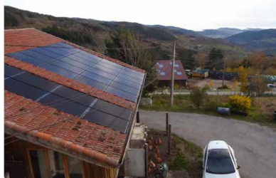
Exemple d'une implantation en encastrement, les panneaux sont à même niveau que les tuiles, Loire
