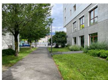
Pied d'immeuble intégré à l'aménagement de l'espace public, entretenu par la ville Allées d'accès aux locaux situés en rdc (bureaux, agence immobilière)
