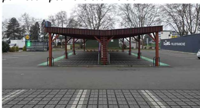
Désimperméabilisation des stationnements à l'occasion de l'implantation d'une ombrière sous des bornes de recharge. Toutefois, les matériaux choisis et l'absence de végétalisation ne parvient pas à qualifier les lieux, Villefranche
