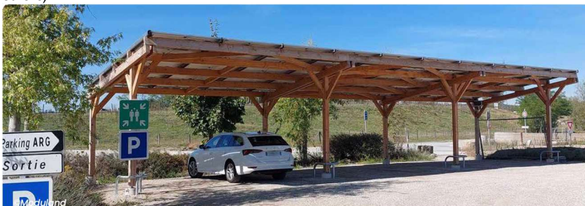
Structure bois (piliers fins, rive et bandeau) et revêtement de sol en terre-pierre.
