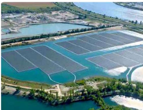
Centrales photovoltaïques flottant sur une ancienne carrière et sur une friche industrielle
