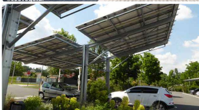
Noue végétalisée récoltant les eaux pluviales entre les ombrières. L'occasion d'espacer les panneaux pour entrevoir le ciel
