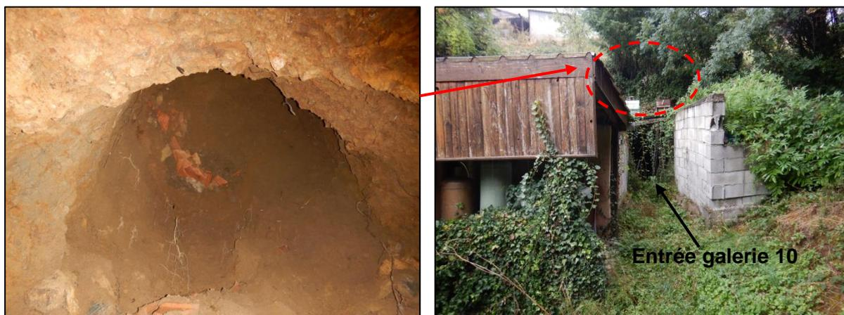
**Figure 15 : Aperçus photos de la montée de voute et situation en surface (ODJ 10, quartier de Berchoux)**
