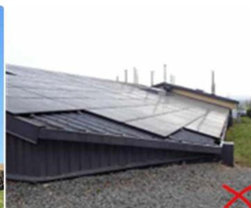
Angle bas de toiture de hangar, générant un décroché des panneaux, disqualifiant l'implantation, Limas
