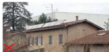
Panneaux sur châssis sur un toit en pente, à proscrire
