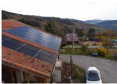
Exemple d'une implantation en encastrement, les panneaux sont à même niveau que les tuiles, Loire
