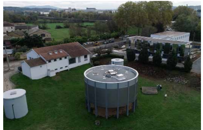
Usine des Traitement de l'eau potable (UTEF)
