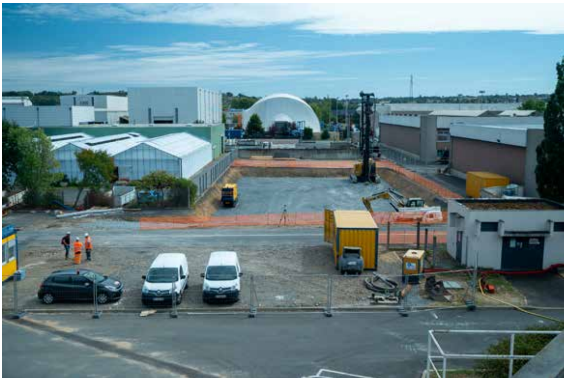
chantier de la STEP
