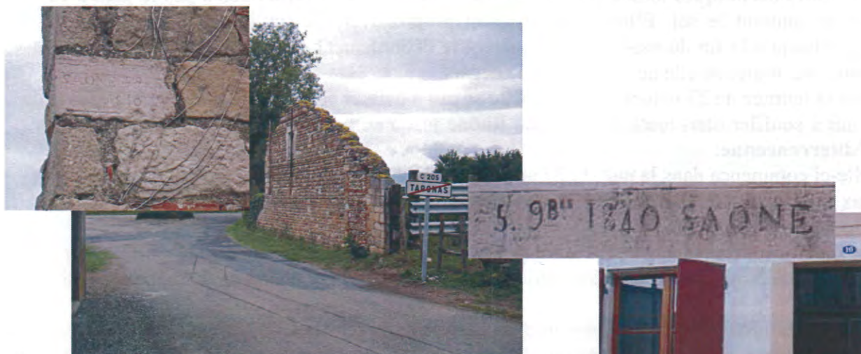
Taponas, repère de la crue de 1840,
